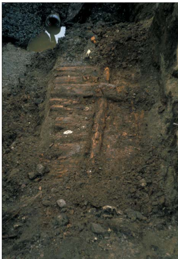
Figur 4. Kavelbroarna under Kanalgatan var välbevarade. På bilden till höger syns skillnaden mellan två olika gatubeläggningar med en längsgående stock som markerar gatans mitt. Foto Viktoria Björkhager, ÖLM.
