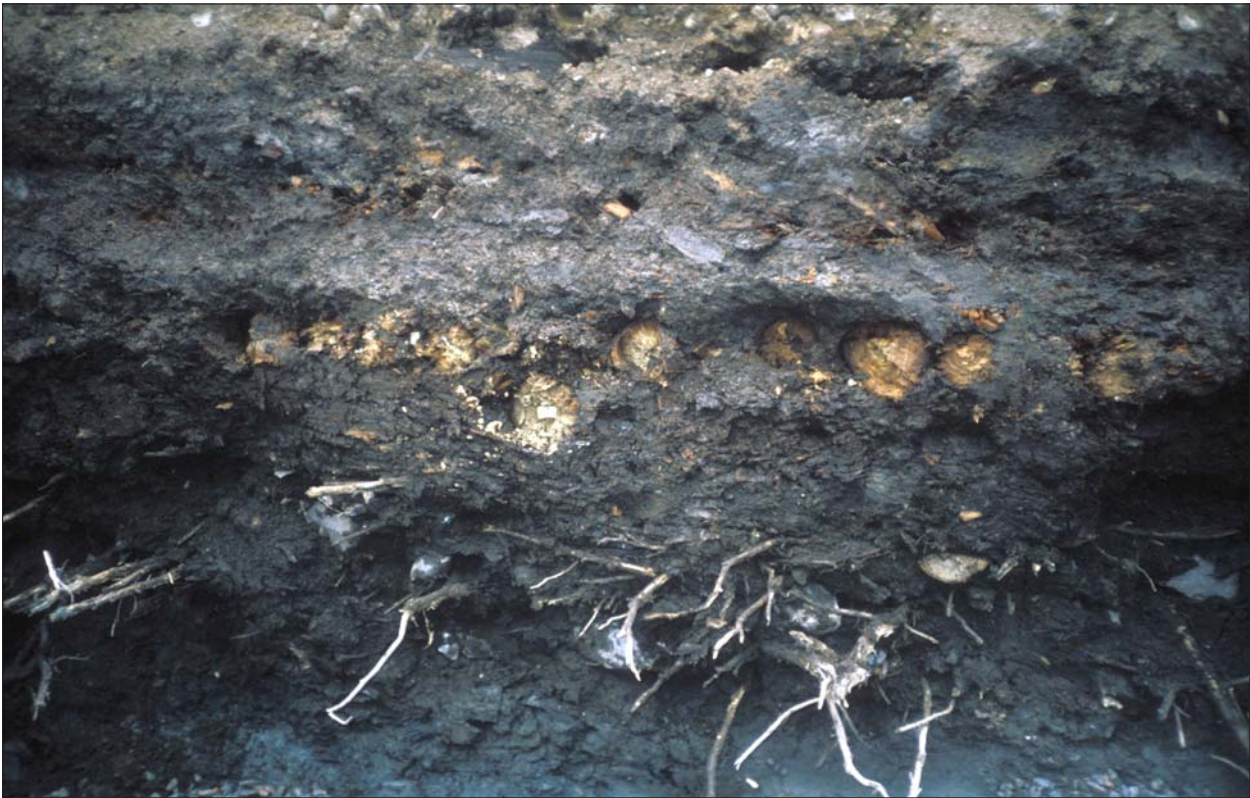
Figur 7. Detalj av schaktvägg med olika gatubeläggningar. Underst risbädd med överliggande stenpackning, där ovan flera omgångar med kavelbroar. Foto Viktoria Björkhager, ÖLM.
