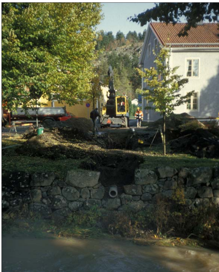
Figur 3. Undersökningsschaktets anslutning mot Storån. Foto Viktoria Björkhager, ÖLM.
