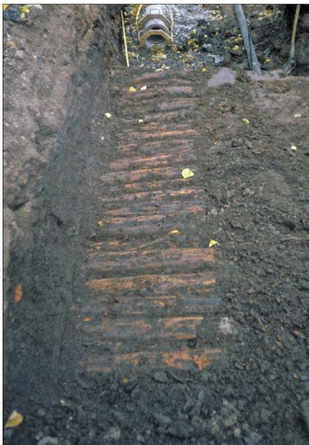
Figur 4. Kavelbroarna under Kanalgatan var välbevarade. På bilden till höger syns skillnaden mellan två olika gatubeläggningar med en längsgående stock som markerar gatans mitt. Foto Viktoria Björkhager, ÖLM.
