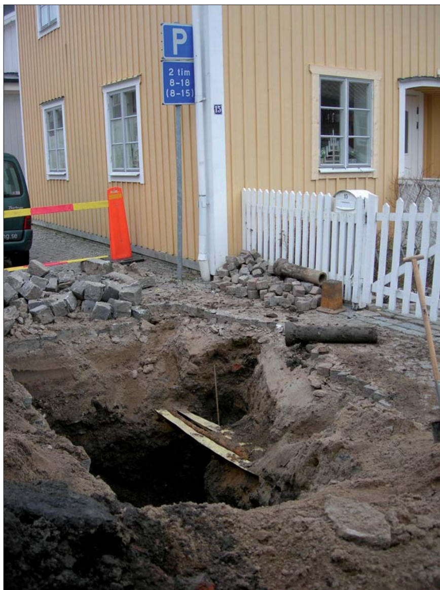
Figur 4. Översiktsbild över schaktet på Munkbrogatan 15. Foto ÖLM.
