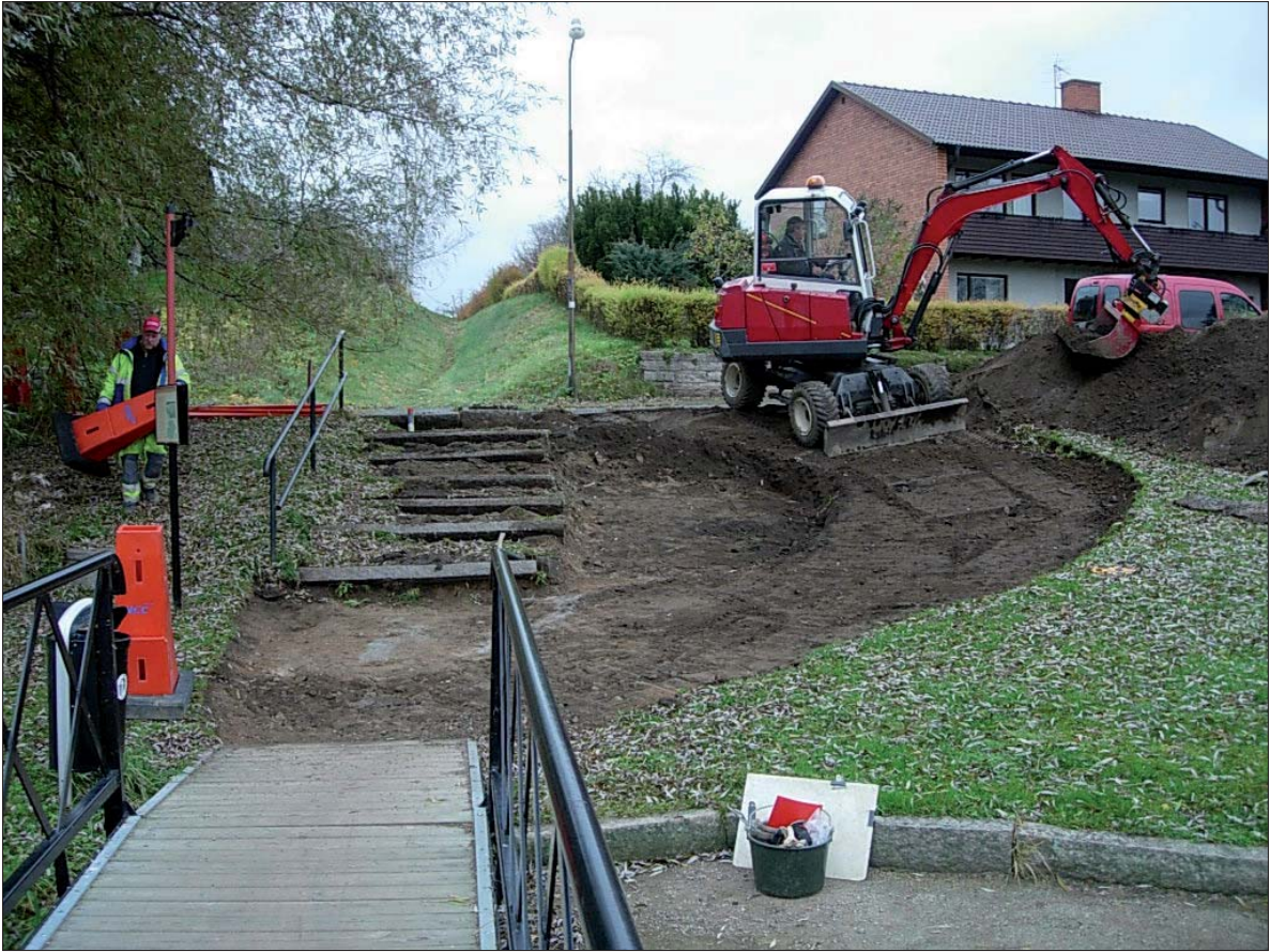
Figur 4. Foto mot NV av schaktet med hålvägen i bakgrunden. Foto ÖLM.
