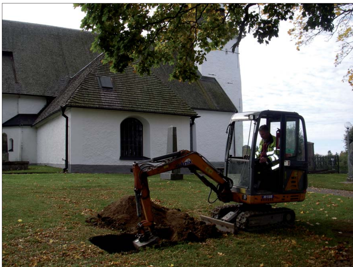
Figur 6. Schaktning pågår. Foto Ann-Charlott Feldt, Östergötlands länsmuseum.
