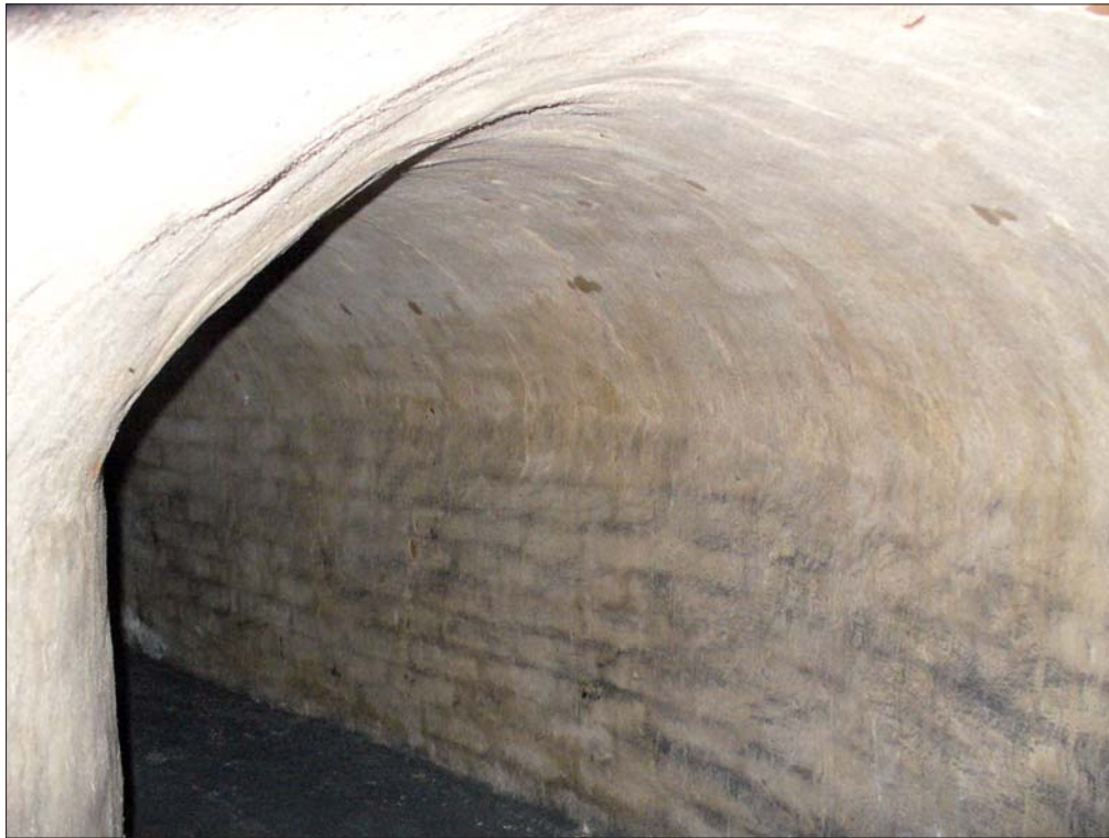
Figur 7. Varmluftskanalen som påträffades under mark. Foto Anita Löfgren Ek, ÖLM.
