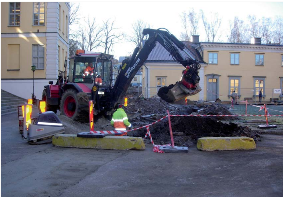
Figur 6. Schaktningsarbete. Mot SSV. Foto ÖLM 2005.
