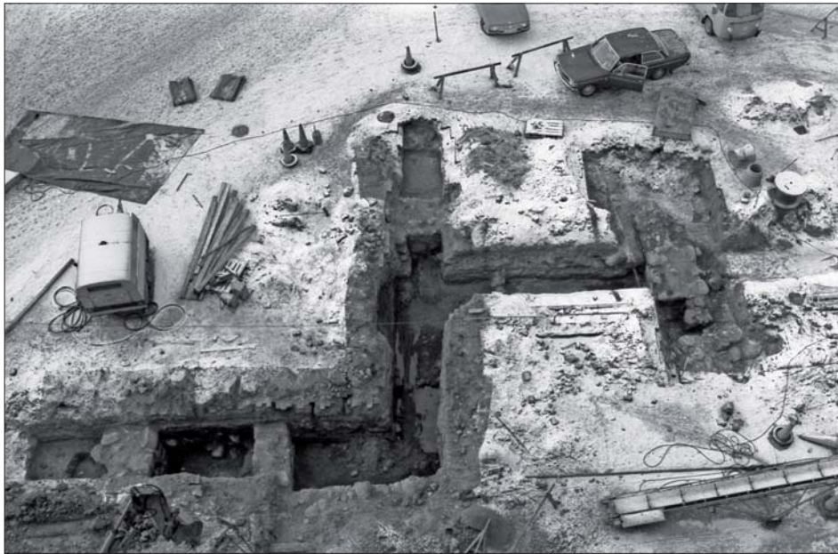
Figur 28. Det månggrenade schaktet på den östra sidan av Stora Torget. I detta schaktet framkom murarna till rådhuset. Foto ÖLM.
