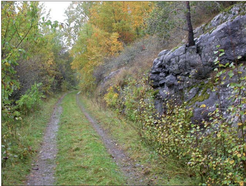
Figur 9. Större delen av VA-ledningen över Lundsbacken och Odensbacken schaktades ner i en gammal järnvägsbank. Från höjden upp mot Odenstugan vidare österut längs Odenbacken var den forna järnvägen nersprängd i berget. Foto Erika Räf, ÖLM.
