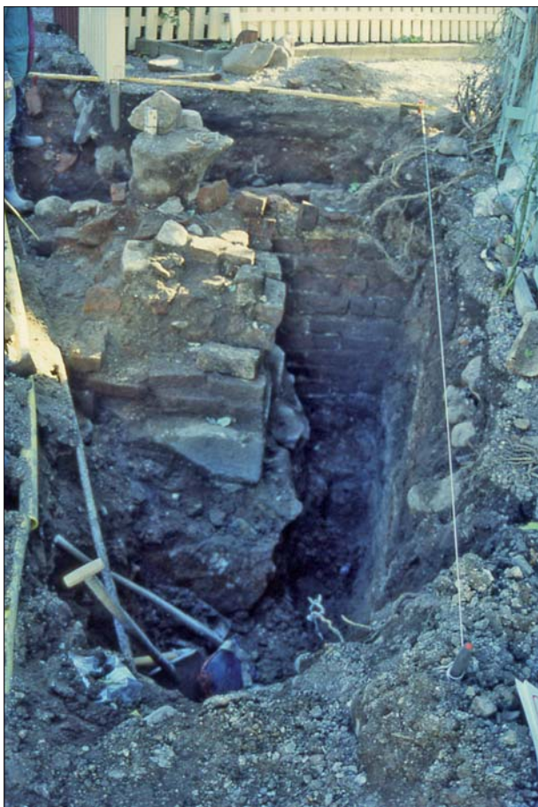
Figur 21. Schaktet var mycket trångt. Husväggen går direkt bakom profilsnöret till höger i bild. Utrymmet mellan väggen och den framstickande strävplaren är 0,6 m. Längst bak i bild den välbevarade kormuren. Av bilden framgår också hur strävplaren är byggd ovanpå kulturlagren. Foto ÖLM.
