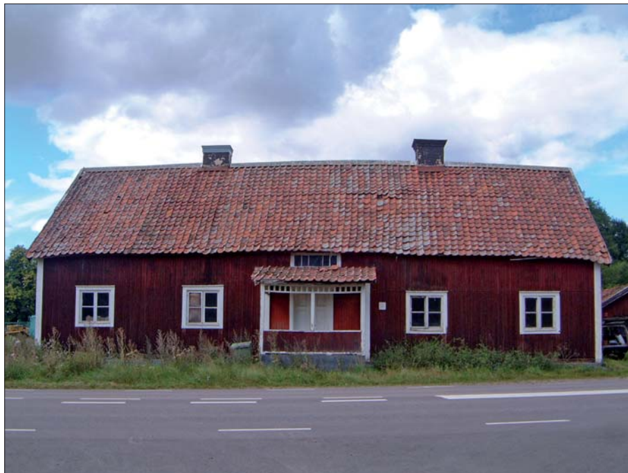
Figur 6. Den gamla arbetarbostaden och före detta Kungsbro motorklubbs klubbhus. Huset ligger mitt emot Kungsbro gårds huvudbyggnad och utgör gårdsanläggningens ena pol, där huvudbyggnaden är den andra. Vapengraven var belägen direkt bakom den före detta arbetarbostaden.
