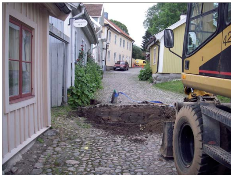
Figur 4. Järntorgsgatan sedd från norr i samband med schaktningarna. Foto Ann-Charlott Feldt, ÖLM.
