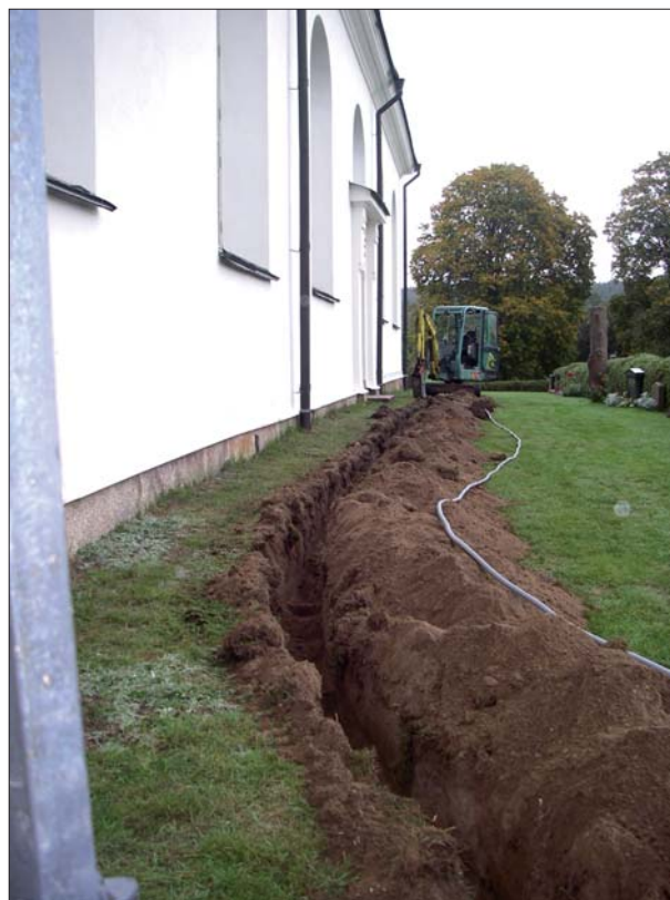
Figur 4. Schaktning pågår längs kyrkväggen. Foto Ann-Charlott Feldt, ÖLM.
