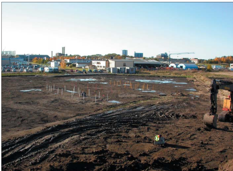
Figur 24. Undersökningsområdets norra del var sankt. Brunnarna framkom i området som skymms av grävmaskinen. Foto mot nordväst. Foto ÖLM.
