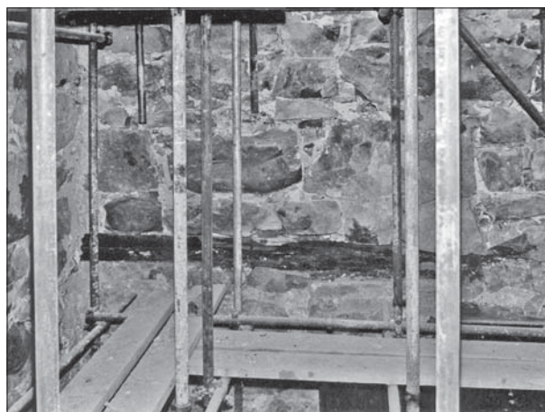
Figur 19. Avlastningsbjälken i den medeltida kyrkans västmur, från väster. Foto Jan Eriksson.
