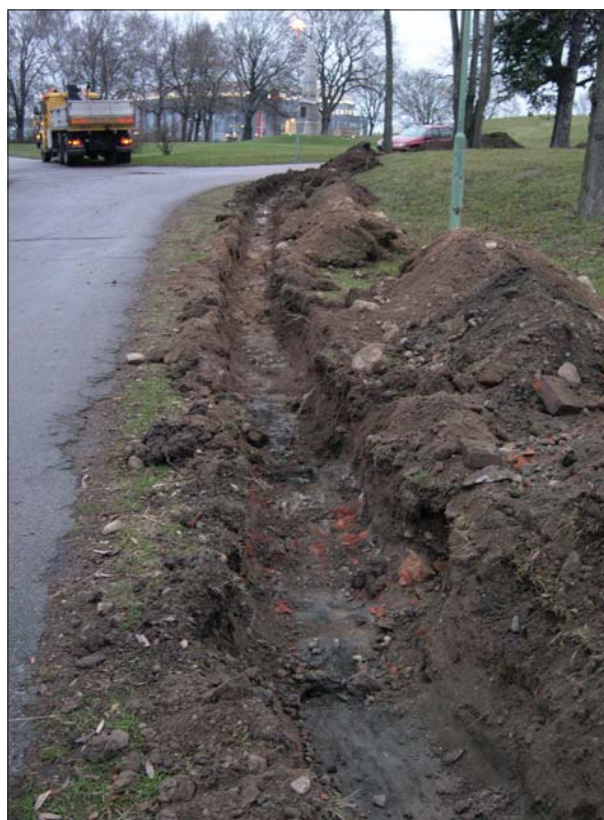
Figur 5. Foto på schaktet.
